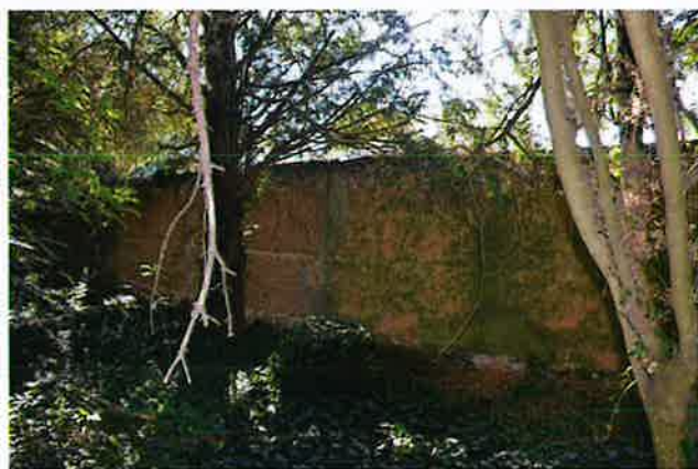
Mur en pisé de la limite sud avec nombreuses anfractuosités
