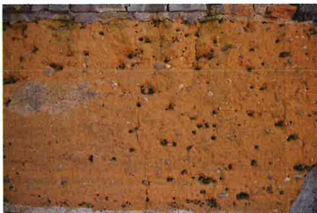
Mur en pisé de la limite sud avec nombreuses anfractuosités
